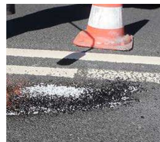
Erhitzen Sie das Material bis es leicht kocht und wiederholen Sie den Vorgang bei Bedarf.
