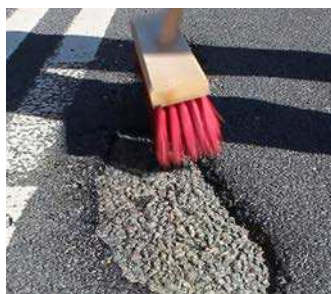
Reinigen Sie den zu reparierenden Bereich.
